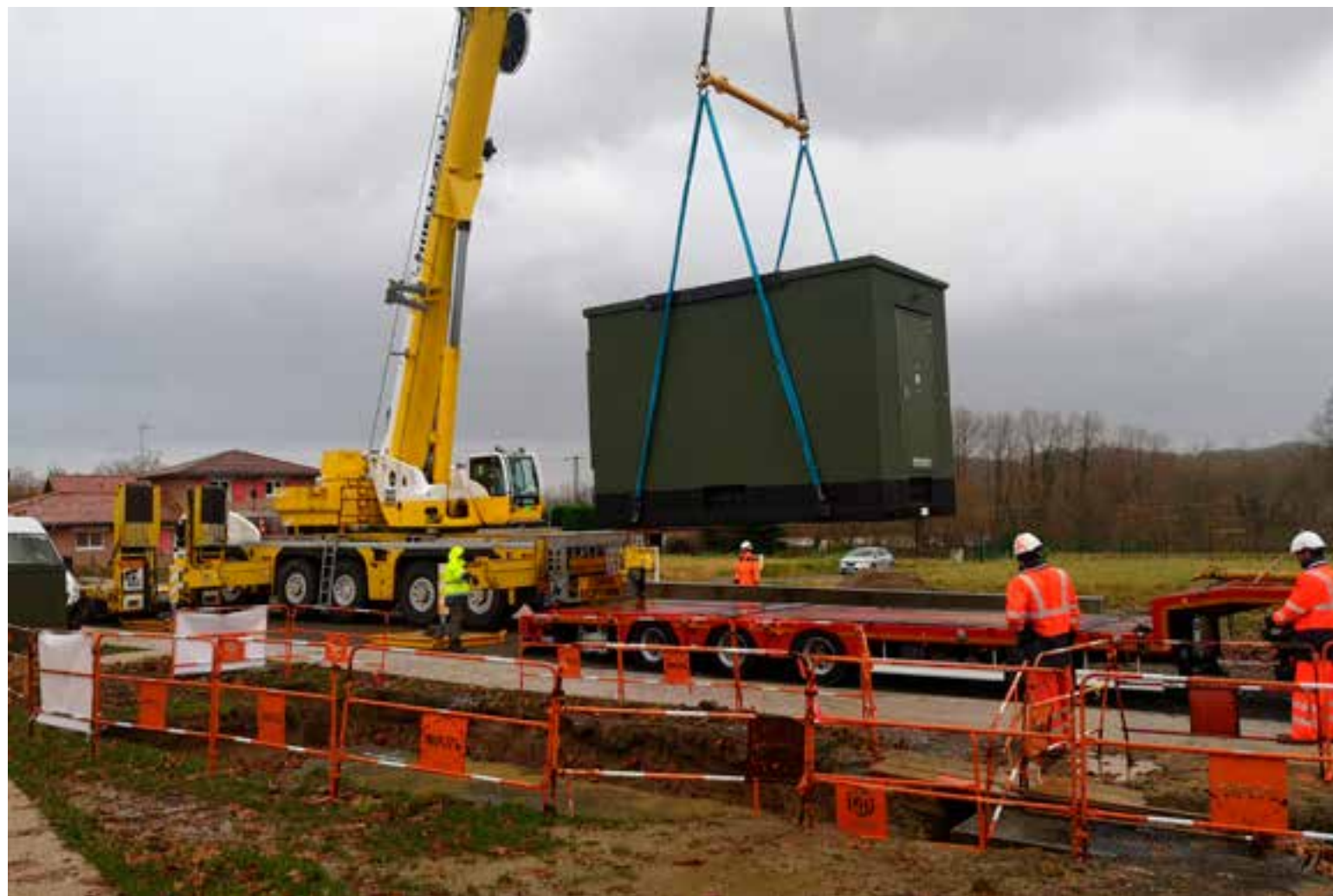
Pose du nœud de raccordement à Cauneille avec la société Altitude Infra.
